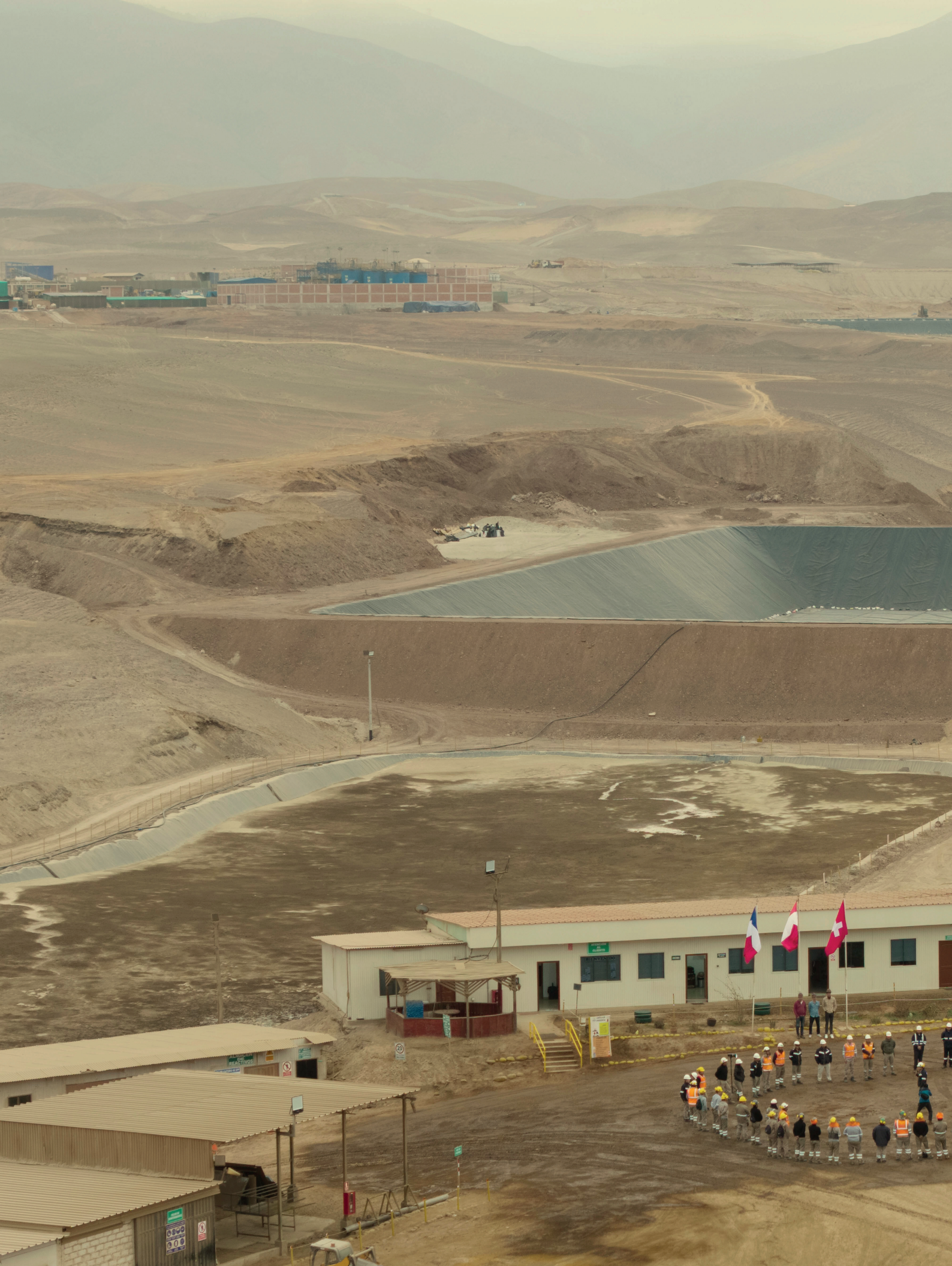
Vue aérienne des installations de Victoria
